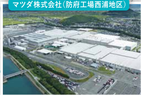
マツダ株式会社(防府工場西浦地区)
